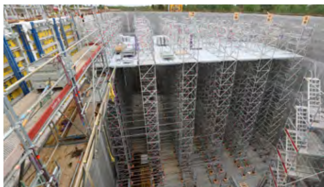
Säker. Inplankad arbetsplattform med räckan.
