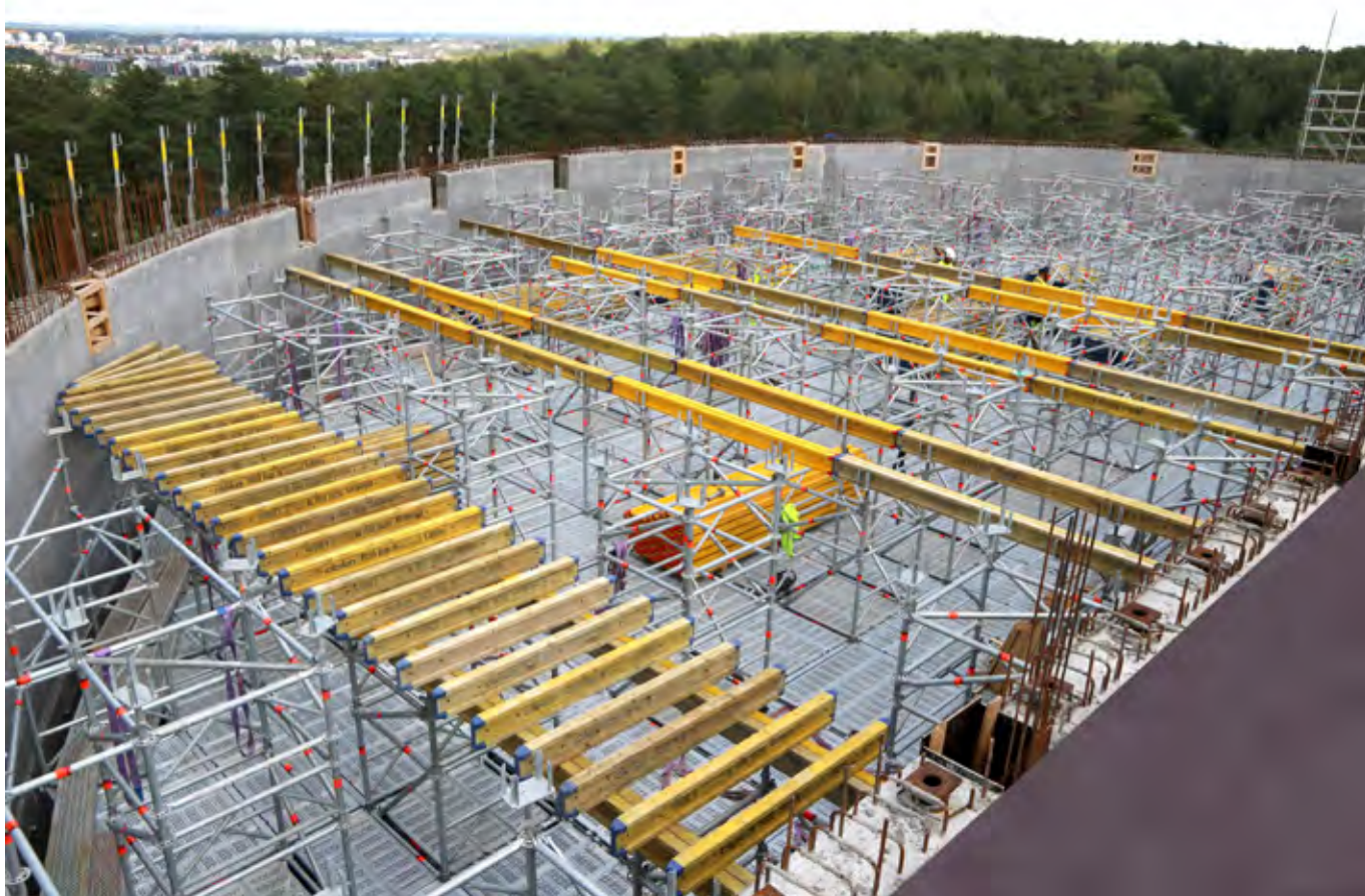
Vattentornet Lyrans diameter är 83 meter. Halva tanken fylld med formställning, 8 000 m 3 .
