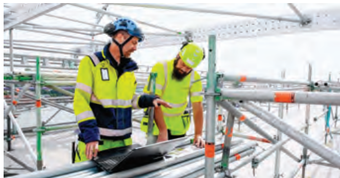
Fredrik Wik, Layher och Robert Åkesson, Scaffolding Projects
