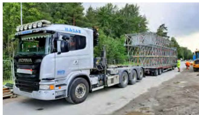
Prefabricera. Lasta och transportera enkelt till bygget.
