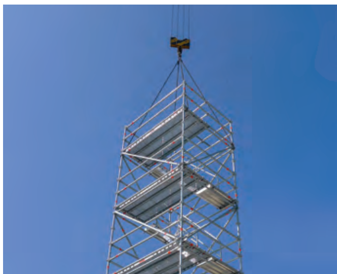
Kranbar. Lyft trappornet i moduler eller i sin helhet.
