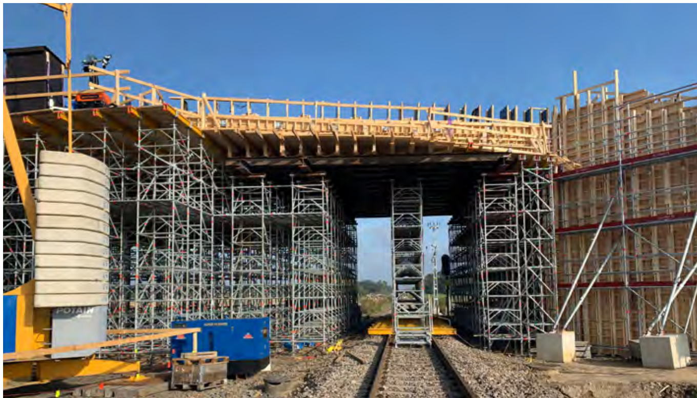
Bro 7. Tånga. Temporärt stödtorn vid gjutning.
