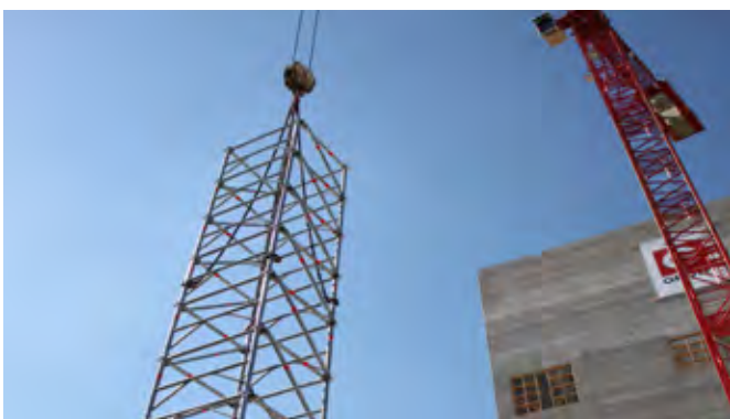
Kranbar. Effektiv byggprocess. Lyft tornen på plats.
