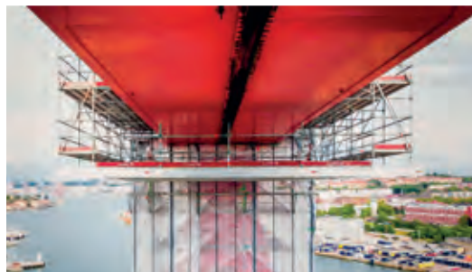
Allround FlexBeam - aluminiumbalk med hög lastkapacitet
