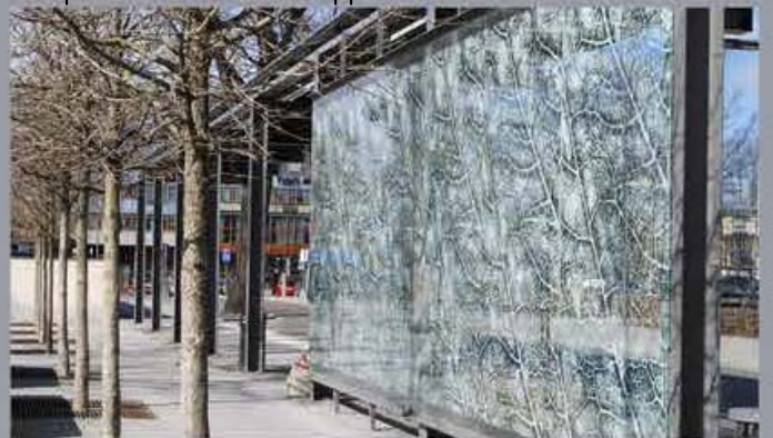
Glaspartier monterat vid Uppsala resecentrum
