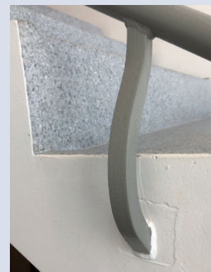
Ingjutet räckesfäste.
